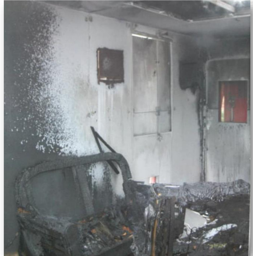
FIGURA 6.3.3.2(a) Combustión limpia en la superficie de la pared.
