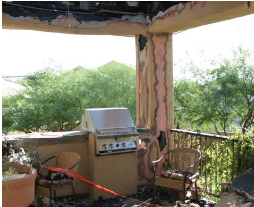
FIGURA 6.3.11.1 Cambios de color producidos por el calor sobre el estuco.
