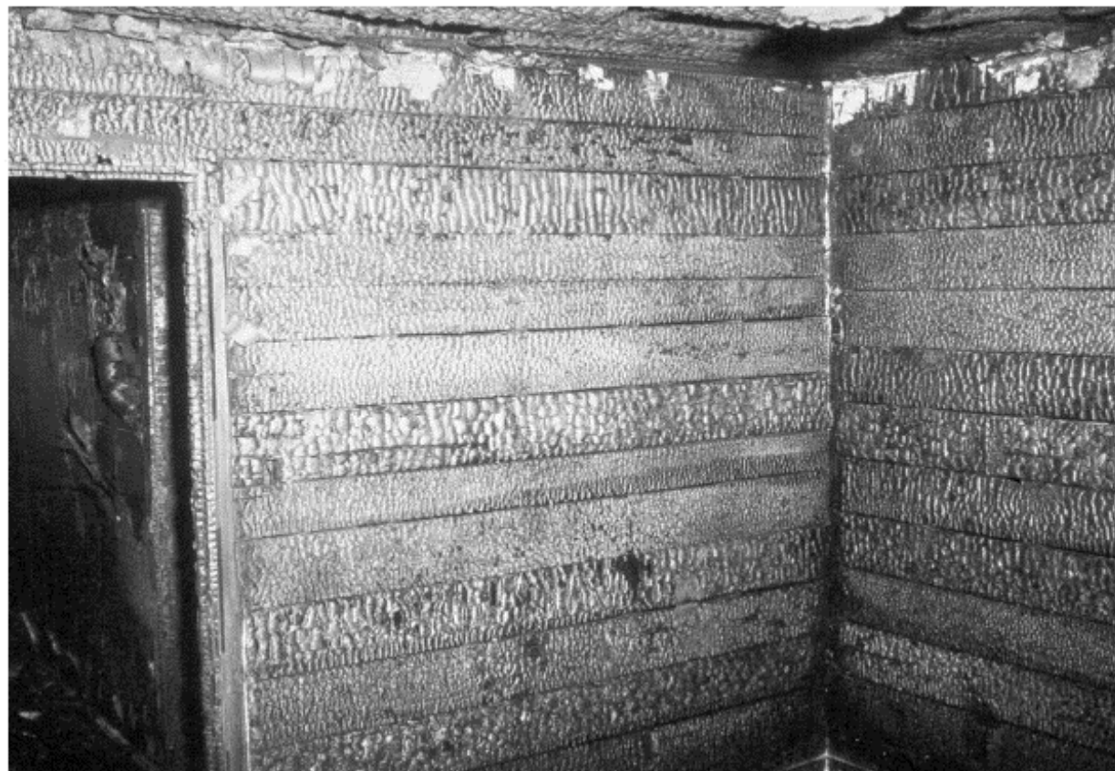
FIGURA 6.3.2.10 Variabilidad de ampollas del carbonizado.
