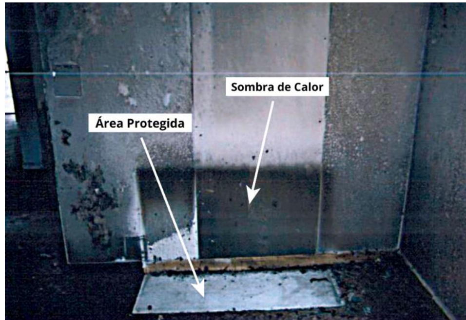
FIGURA 6.3.18.3.1 (a) Sombra de Calor y Áreas protegidas (Proyecto USFA sobre Marcas del Fuego)
