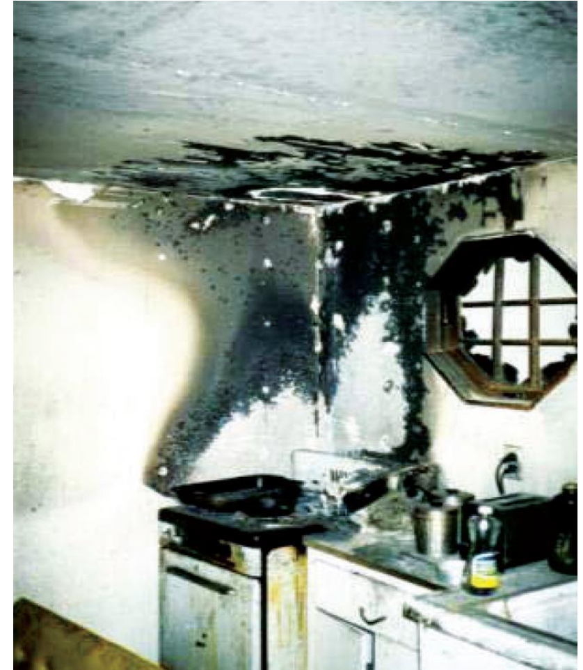
FIGURA 6.3.20.3 Marca con forma de “reloj de arena”
