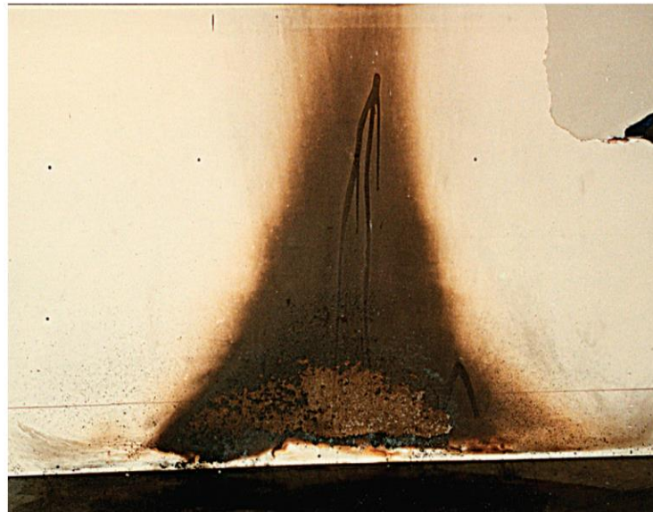
FIGURA 6.3.20.2.1(b) Marca de cono invertido producida por la quema de una pequeña pila de papeles.
